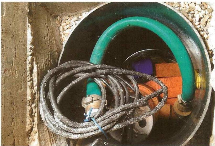
Aanleg van het drainagesysteem met pompvoorziening aan de Floralaan Oost in Eindhoven.
